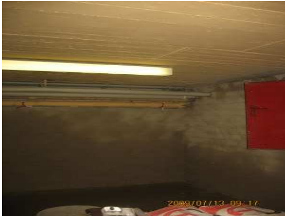
Bild 6: aerodurit® Entfeuchtungsputz arbeitet. Obere Bereiche bereits 1Tag nach Putzauftrag trocken.
