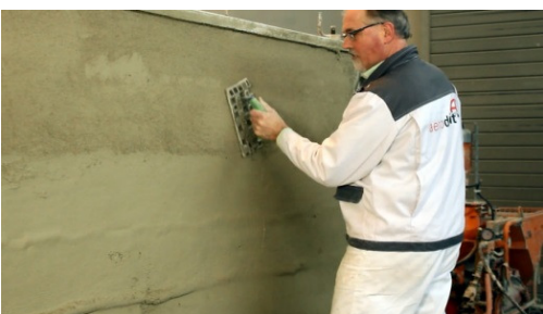
Sinterschichten entfernen
